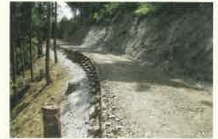
長野さん開設の作業道 丸太組工法
