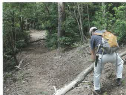
自然歩道の補修作業の様子
