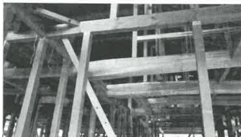
＜桶狭間で作成中の寺院の内部＞ 木材に段ボールを巻いて、傷ができるのを防いでいる
